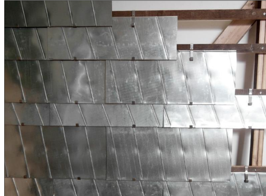
Flatvalsede ventilasjonskanaler montert som veggkledning. Demonstrasjonsmodell, Nordic Built Component Reuse 2014
